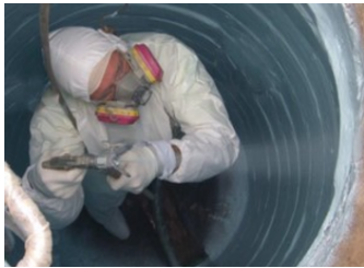
Manhole Rehab Pic
