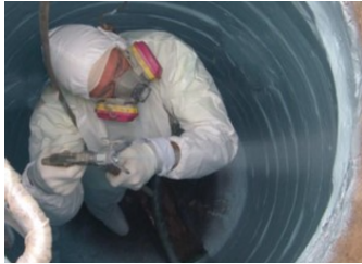
Manhole Rehab Pic
