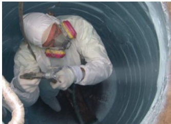
Manhole Rehab Pic
