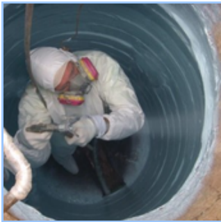
Manhole Rehab Pic
